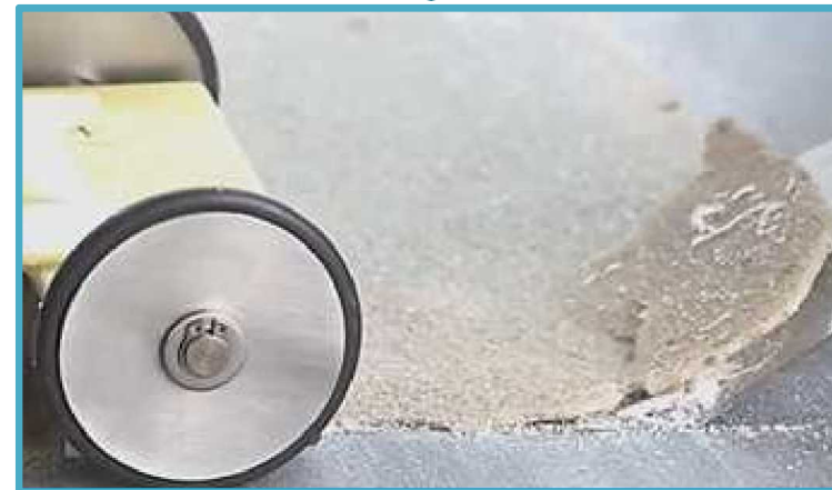
剥離した被膜はスクレイパー等で容易に除去
