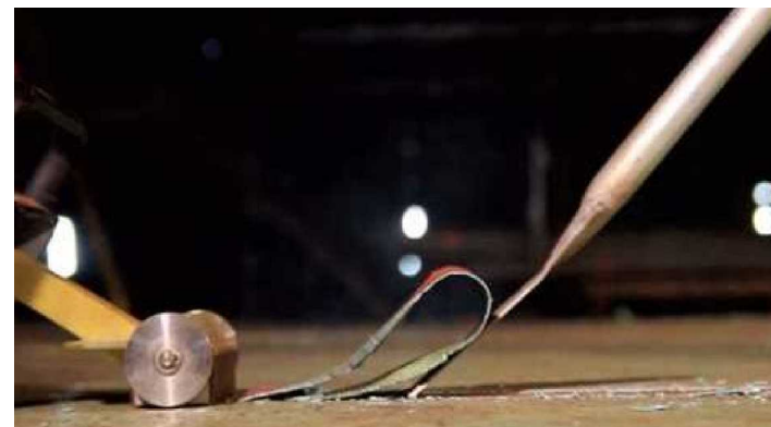
タンク内のガラスフレークライニング状況
