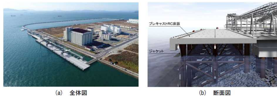
図1 プレキャスト RC 床版を用いた栈橋の完成イメージ [出典：中国地方整備局宇野港湾事務所]
