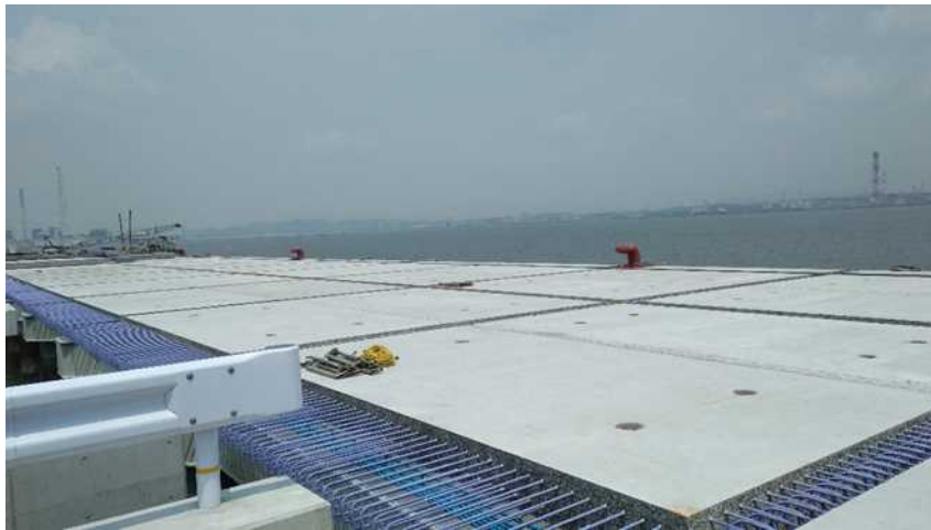
RC床版据付け完了
