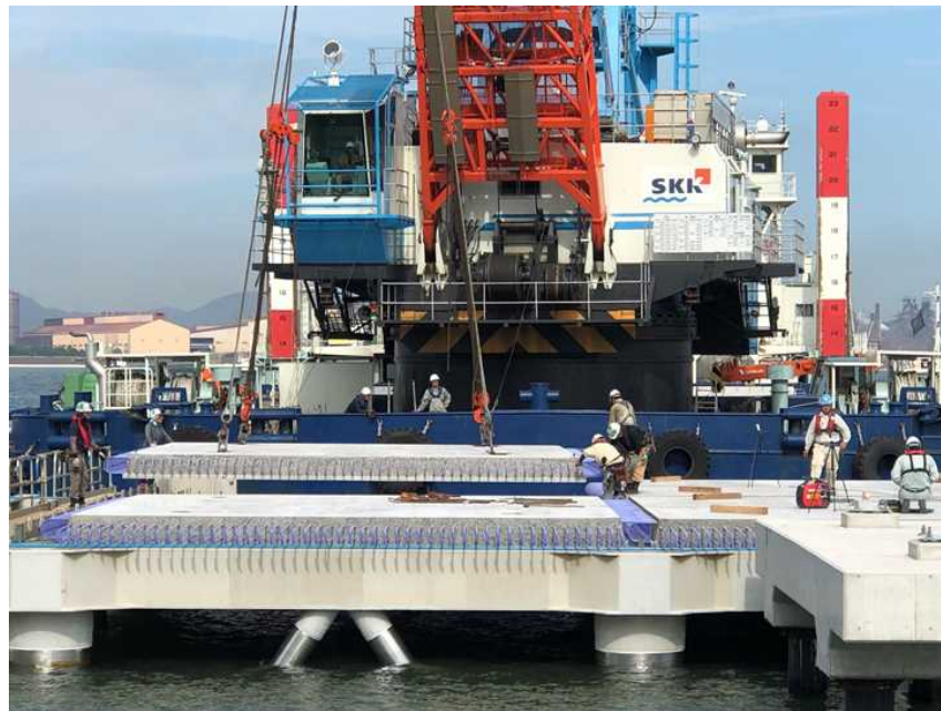
ジャケット式棧橋床版 中国地方整備局宇野港湾事務所
