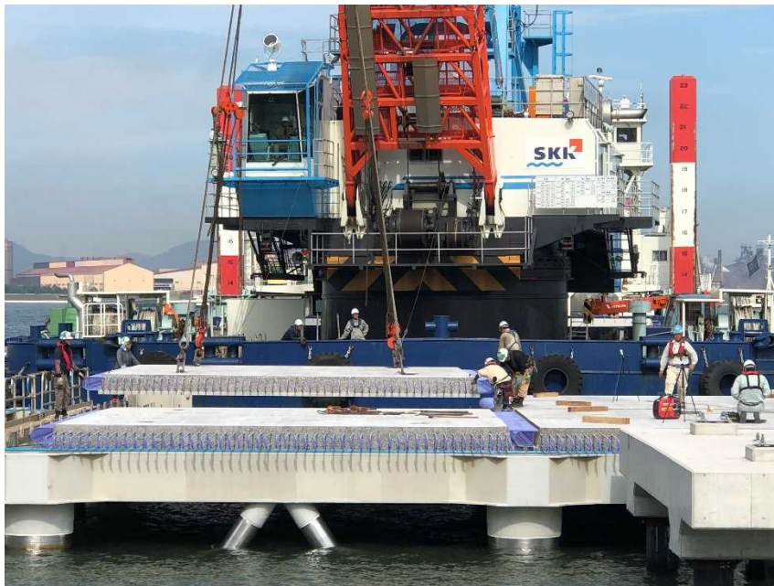
RC床版据付け状況
