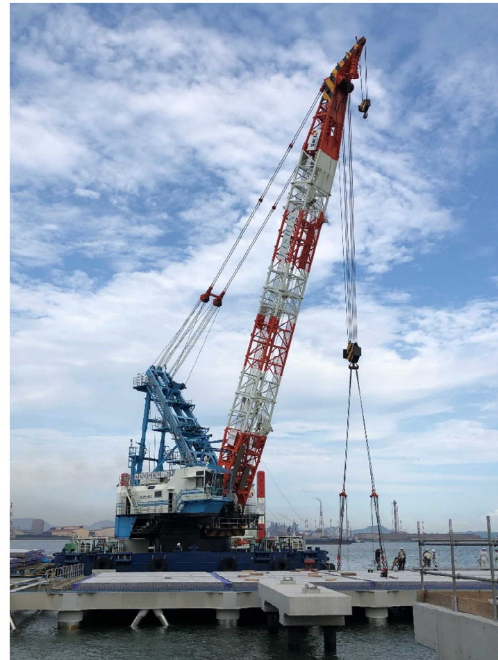
RC床版据付け状況
