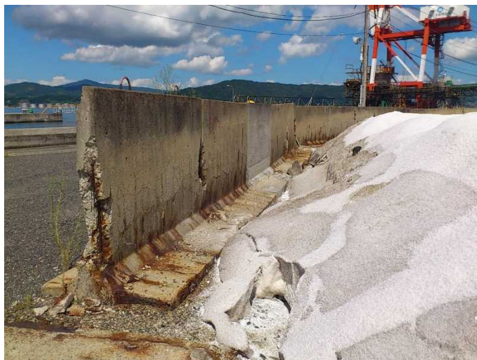
普通コンクリート
