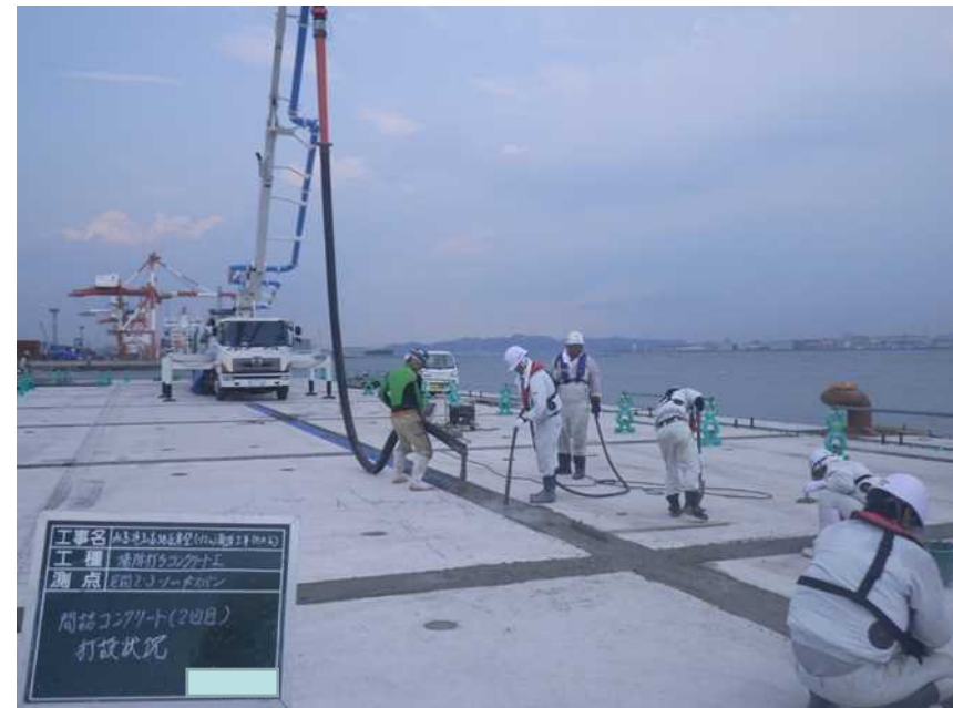
間詰コンクリート打設状況
