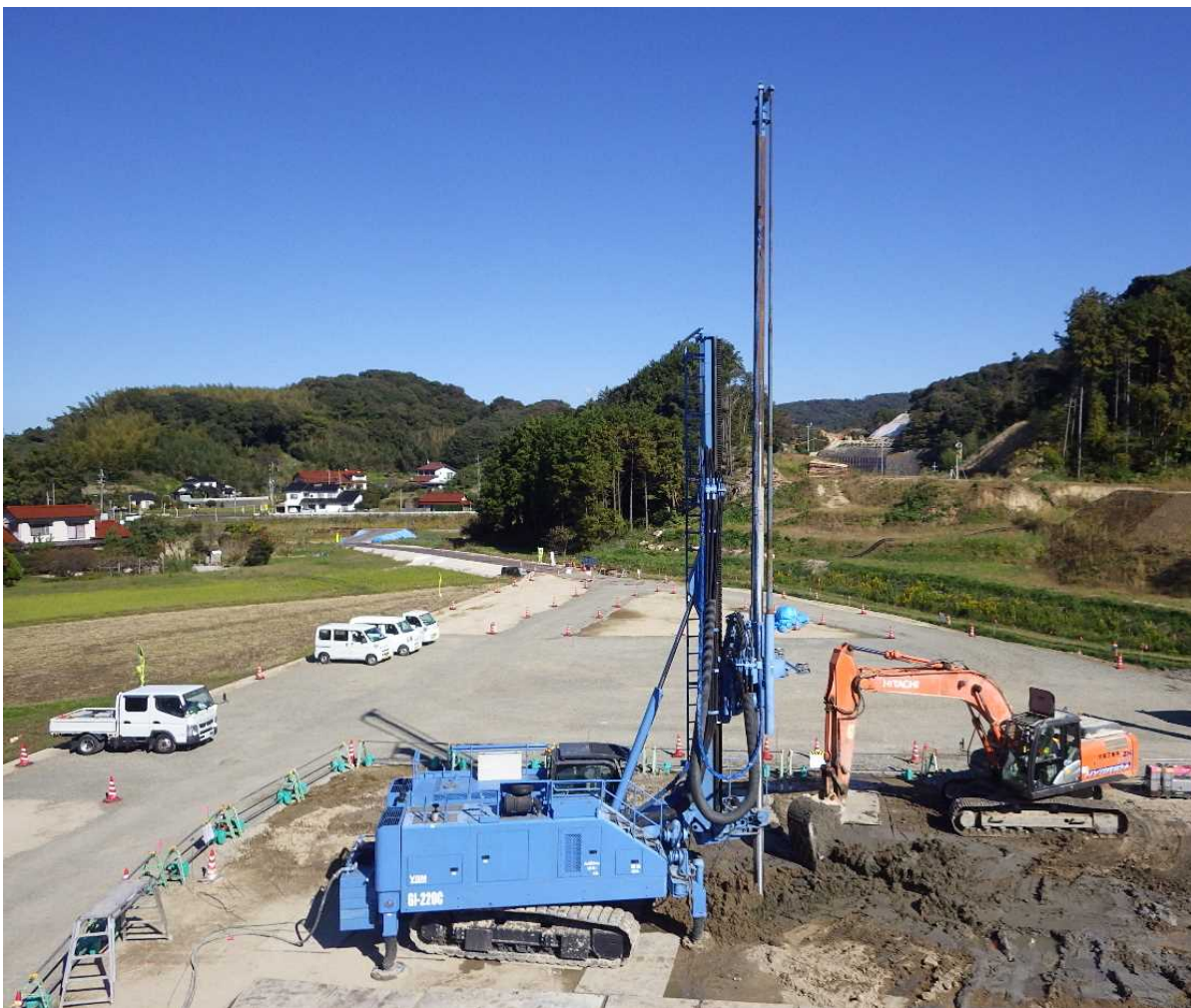
GI-220C搬入状況
