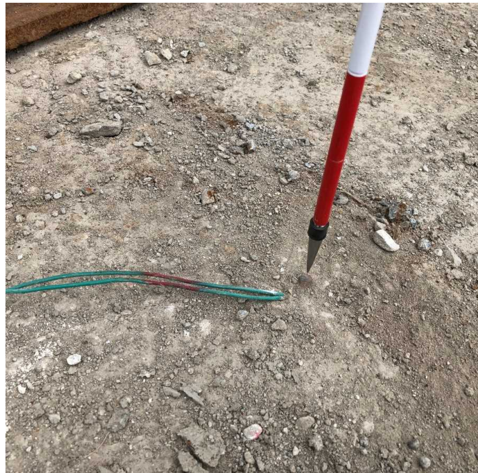
杭芯セット完了
