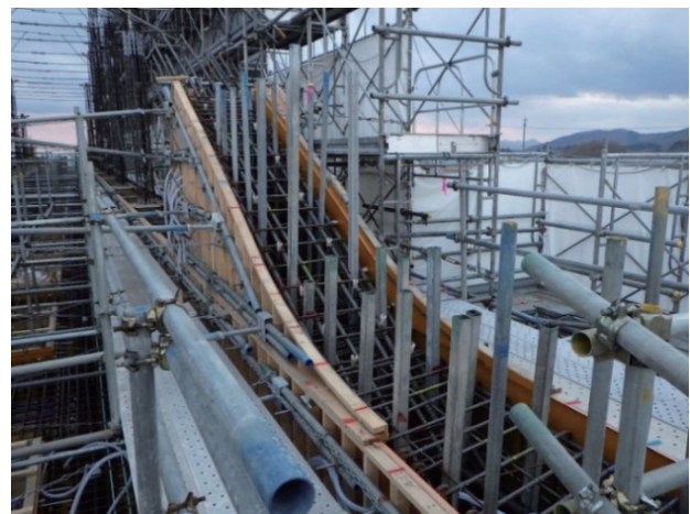
写真-1 バイブレーター挿入スペース確保(例)
