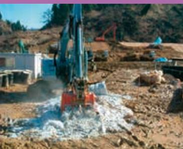
**繊維質固化処理土工法(高含水比泥土の再資源化)**
