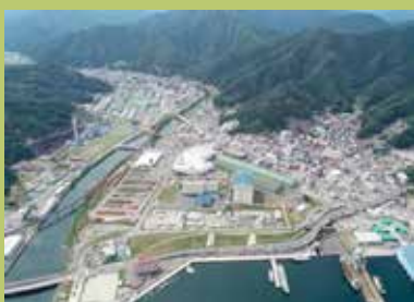
岩手県釜石市中心市街地
