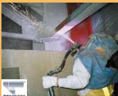
**亜鉛・アルミニウム擬合金溶射皮膜により鋼構造物の長寿命化を実現する防錆・防食技術**
