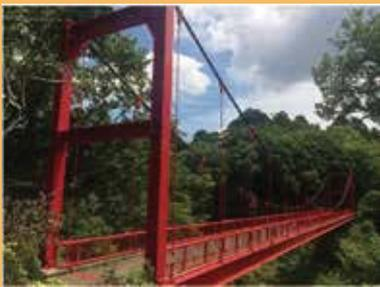
さびの特性を生かした橋梁の長寿命化に役立つ錆転換型防食塗装
