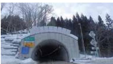
トンネル・スノーシェッド坑口や道路際のコンクリート擁壁上などに発生する雪庇を抑制し、その成長を防止する製品です。
