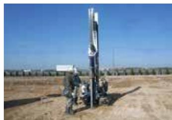
地面に直接打ち込むだけ、事前作業も事後養生も残土処理も不要です。基礎打ち直後に上物の設置ができ、将来、撤去する時もとても簡単で、30度程度の法面でも対応可能です。作業日数の短縮とコストダウンを両立します。グループ全体で10万本以上の施工実績を誇っています。
