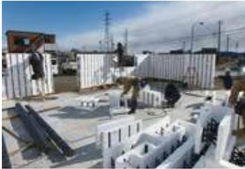
SISJ工法は、内外両断熱型枠材を使用した鉄筋コンクリート型枠壁式構造の建築工法です。難熱性発砲ポリスチレン（EPS）を用いた型枠で、コンクリート打設後はそのまま内外断熱材として脱型をせずに利用でき、工期短縮が図れます。
