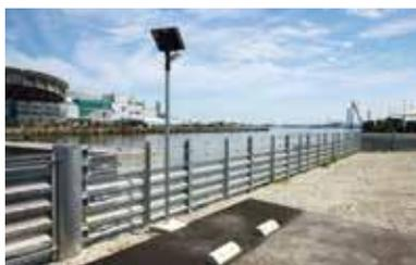
津波ガードは海岸沿いの道路や港湾施設に設置することで、平時には越波や波しぶきによる交通障害や浸水を防ぐ役割を担う。また、透過性のある構造にする事に依り、津波来襲時は、堤防からの越流に比べ早く少量づつ海水が流入し、早めに危険を察知でき、避難時間を確保出来る。さらに、引き波の滞留防止効果も期待できる。透過性のない通常の防潮堤に比べて岸沖方向の視野が格段に広くなり、景観の面でもメリットが大きい。
