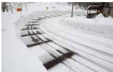
「地中熱」は足元に眠るもっとも身近な再生可能エネルギーです。その熱エネルギーは深さ15～20m程度で10～16℃ほど。この熱エネルギーをヒートパイプで直接採熱し、路面の融雪に利用するのが「地中熱ヒートパイプ融雪システム」です。システム構造はシンプルで、深さ20m程度のボーリング孔に数本のヒートパイプを挿入するだけです。このヒートパイプは、降雪や気温低下により路面が冷却され、地中と路面との間に一定以上の温度差が生じると自動的に作動し、地中熱エネルギーを路面に運びます。そのため、地中熱以外の一切のエネルギー、一切の制御機器も使用せずに融雪を行うことができます。
