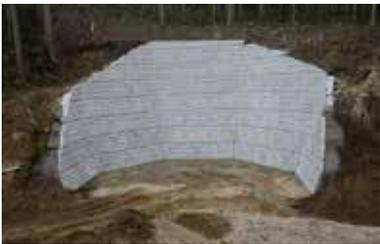
PAN WALL工法は、地山補強土工法の理論に基づく斜面安定技術です。表面工にプレキャストコンクリートパネルを使用、急勾配化（垂直～5分）により改変面積を最小化、段階的な「逆巻き施工」を基本とした施工安全性の高い工法です。さらに、ブロック積み擁壁などの既設構造物の補強や、耐震・防災にも威力を発揮し、豪雨災害復旧にも活用できる最新の地盤工学技術です。これまでの施工実績は全国に780件以上、施工面積は24万㎡以上です。
