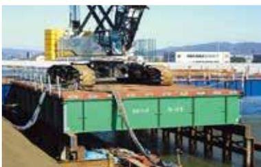
橋長は14mから2m毎に伸ばすことが可能です。部材長は10m以下で搬入し、現地で組み立てるスペースがあれば、大スパンに対応が可能です。軽量型のTYPE-Iは緊急用の仮設道路橋として最適です。重量型のTYPE-IIは、高強度であり工事用栈橋として使用します。スーパーガーダーの特徴は、主桁間隔をTYPE Iの2mと3m、TYPE IIの1m、2m、3mとする事ができ、設計条件に応じた最適設計が可能です。①桁間隔 1.0m 対応により、適用スパンが飛躍的に伸びます。②桁間隔 3.0m 対応により、主桁・支持杭本数の削減によるコスト削減・工期短縮が期待できます。
