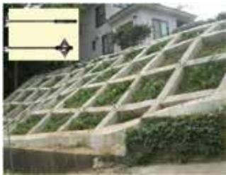
土地の有効利用や自然環境への配慮の観点から、安定でかつ経済的な切土のり面の急勾配化のニーズが高く、鉄筋などを地山に挿入して掘削面や斜面の安定を図る地山補強土工法が普及しています。ミニアンカー工法も、この地山補強土工法の一つです。ミニアンカーは地山挿入後に先端が拡大できる構造で、拡大部の支圧抵抗により通常の補強材に比べて「補強材長を短くでき、補強材配置ピッチも広く取れるため」使用本数が削減できることから、建設コストの抑制、工期短縮が図れます。ミニアンカー工法は補強材の長さを短くすることができるため、特に敷地境界の厳しい箇所への適用に効果を発揮する防災・安全技術です。
