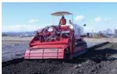
「STB工法」は軟弱地盤や軟弱土質の土質改良に混合精度が良いスタビライザを用いて改良する「浅層地盤改良工法」です。最大深度1.2mまで混合可能です。主にセメント系や石灰系の固化材を用いる化学的固結改良工法と、単独では利用できない建設発生土を粒度改良によって改善した上で築堤盛土材として再利用する河川ブランクネット工事等の物理的改良工法があります。また昨今問題視されている有害物質の封じ込め等、幅広く利用できる工法です。東日本大震災復興復旧工事には多くの現場で採用いただいております。
