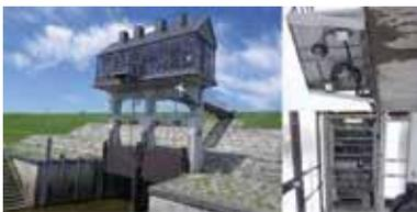
水門・樋門のゲート設備について、監視カメラの画像解析により導き出される水位、水位計により計測される水位の複数情報を基に、設定条件時に自動でゲート操作を行うシステムです。従来は、操作員が水位計および量水標等の水位を観測し、操作水位と判断した場合に人為的にゲート操作を行っていましたが、本システムにより以下の効果が期待できます。
