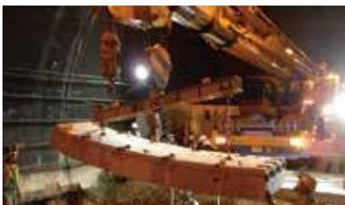
交通量の多い幹線道路トンネルの盤ぶくれ対策として、夜間全面通行止で施工し、昼間全面開放が可能なプレキャストコンクリート製インバートです。
