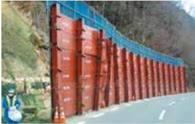
本技術は、鋼製のパネルを利用した落石防護柵です。従来、道路改良の法面工事や崩落災害の発生時に仮設の防護柵を設置する場合、H鋼支柱に鋼矢板を溶接や金具で1枚1枚取り付けていましたが、「パネル式防護柵」では専用固定金具を支柱にボルトで2箇所取り付けてガイドポストを固定し、パネルを上から差し込むだけなので設置・撤去の作業性が大幅に向上しました。活用メリットとしては ①設置・撤去の工期が短縮できます ②パネルと支柱の連結性が高く落石の衝突エネルギーを吸収できます ③設置・撤去に特殊な技術を必要としません ④緊急災害発生時に材料の入手が容易です
