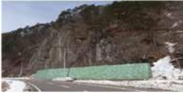
Geo BANK工法 (ジオバンク工法) には落石に対応するRGB工法 (ロックジオバンク工法)、雪崩に対応するSGB工法 (スノージオバンク工法)、崩壊土砂に対応するEGB工法 (アースジオバンク工法) の3つの分類がある。道路際または斜面上にジオグリッドを用いた補強土壁を構築し、落石、雪崩、崩壊土砂から保全対象物を防護する、または落石、雪崩、崩壊土を進行方向を変えて安全な場所へ誘導することが可能な工法である。RGB工法は、落石衝突面で衝撃荷重を分散させるために緩衝体に高密度ポリエチレン製の立体ハニカム構造のジオセル、中詰材に単粒度砕石を用いており、最大4500KJ～程度の落石エネルギーに対応することができる。
