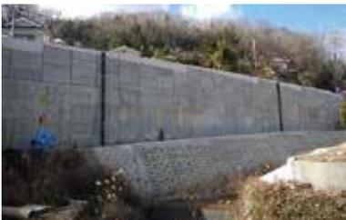
CAB WALL工法は、従来の地山補強技術と盛土補強土壁の技術を複合し、道路拡幅工事や谷あいの道路新設工事等に活用できる「複合補強土壁」です。従来の道路拡幅工事は、交通規制（通行止め）や軽量盛土などで対応していたが、本工法は下部に地山補強土を配置することにより背面掘削を低減し改変断面積を小さくすることで交通規制を縮小する、環境負荷の低減や利用者負荷の低減にも貢献できる工法です。
