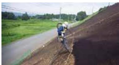
短繊維材を植生基材に混合することで生育基盤の強度が向上し、降雨に対する耐侵食性は金網張工と同等の効果が得られます。
