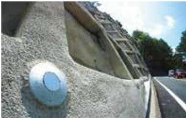
フラットキャップは、地山補強土工（鉄筋挿入工）の頭部定着を地中でおこなうことで、地表面の定着余長を不要にし、表面に突起物をつくらなくすることができる頭部定着部材です。◆従来のように保護キャップが突出しません。◆補強後の斜面に、スッキリとした景観を提供します。◆車両や歩行者などと接触する危険がありません。◆落石などが衝突することによる破損がありません。◆除草、除雪などの維持作業の障害にもなりません。◆防錆油を使用しないので、流出のおそれはありません。◆従来の補強材を使用するので、設計計算は変わりません。◆部品点数が少なく、経済的です。◆施工者に制限がなく、誰でも使えます。
