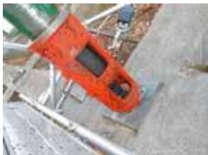
グラウンドアンカーが日本に導入され50年が経過し、グラウンドアンカーの老朽化による性能低下が確認されています。これらのグラウンドアンカーの多くは「旧タイプアンカー」であり現在の永久アンカーに比べると防食性能に問題があります。
