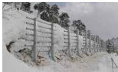
①法面に対して鉛直に設置することにより、巻きだれの発生を抑制します。
