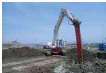
「STB-PMX工法」は軟弱地盤にバックホウの先端に取り付けた左右対の円形直接駆動方式の攪拌機を用いた浅層・中層地盤改良工法です。
