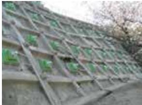
EHDアンカーは、先進的な耐食性を有する付着型ECFストランドを使用して、構造物対策用途として供用100年以上の超高耐久性を有します。
