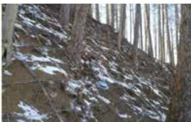
地山に挿入した補強材(ロックボルト)と地表面に敷設したユニットネットを支圧板で連結し、これらの相互作用で斜面の表層崩壊を防ぐ工法です。
