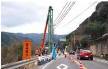
マストドリリングシステムは、補助マストに備え付けられたロータリー式削孔機と、削孔ツールを懸吊したクレーンで構成する大口径ボーリング工法です。◆補助マストの荷重支持でクレーンの負荷を軽減し、クレーンの小型化、作業半径の拡大を実現しました。◆マストドリリングシステムでは、現場条件を考慮し「エアロータリー工法」「ダウンザホールハンマ工法」「マッドロータリー工法」から最適なシステムを選択します。◆ベントナイト泥水を使用しない工法では、産業廃棄物を出しません。◆回転掘削をおこなう工法では、地盤に振動を与えません。◆システムがコンパクトなので、使用機械が小型化され、騒音・振動を低減します。
