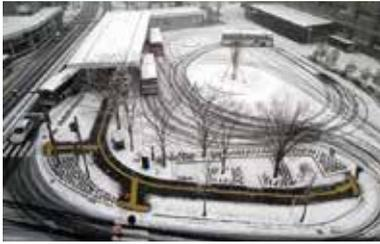
再生可能エネルギーの一つとして活用が期待される“下水熱”。その用途は、空調分野に限らず消・融雪分野にも広がり始めています。下水熱の温度は冬でも10℃以上あり、消・融雪設備にとって十分な温度です。そこで当社では、未処理下水が流れる下水管路内からヒートパイプで直接採熱する「ヒートパイプ方式」、管底に張り巡らせたパイプで直接採熱する「管底設置型熱交換方式」のほか、下水処理水の熱をヒートポンプでさらに高めて利用する「ヒートポンプ方式」など、下水熱ポテンシャルと融雪ニーズをマッチングさせた様々なタイプの“下水熱利用融雪システム”の開発・設計・施工に取り組んでいます。
