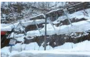
スロープガードネットSタイプは、積雪地域の急斜面等で発生する崩落雪対策として開発された崩落雪防護網です。シンプルな部材で構成され、ネットを主部材としているため透過性が高く、景観にも配慮されており、アンカー基礎構造なので、大規模な斜面掘削を必要としません。切土斜面に設置することで用地の購入を最小限にすることができ、道路際でも設置することが可能です。そのため従来工法と比較して、施工性、環境性、経済性に優れています。
