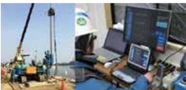
ICT-JETは、国土交通省が推進しているICT技術（情報化施工）に対応でき、高品質な施工を可能にする目的で開発した高圧噴射攪拌工法の管理システムです。
