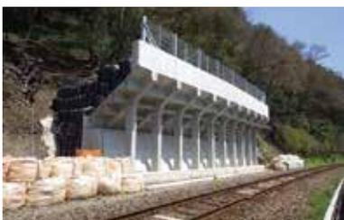
道路際や線路際に設置し、斜面から落石や小規模雪崩を受け止め、防護対象物の安全を確保する構造物です。プレストレストコンクリート製の梁と柱を工場で作成し、現地に運搬したあとクレーンで架設するので、短期間で構築可能な経済性に優れた工法です。
