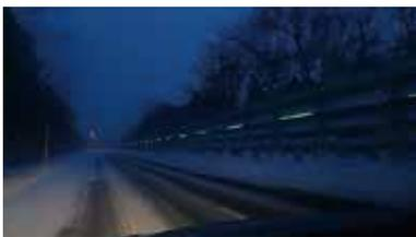
本技術は、ホワイアウト発生等による視程障害において、道路線形に沿った防雪柵に高輝度SMDを用いることで、連続した光の線がドライバーの安全な走行のサポートをするとともに視覚を通して安心感を与える視線誘導技術である。
