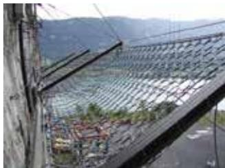
20年の実績を持つリングネット落石防護柵に、変形量を抑制した新しいタイプ(RXE)が加わりました。
