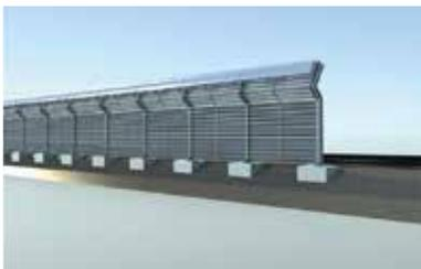
従来の高性能防雪柵における視程障害の緩和領域は柵高さの約7倍を有し、風下側への吹き溜りが少ないことが特徴であり、それまでの吹止柵と比べ路肩近傍への設置を可能としていた。この従来の高性能防雪柵の防雪効果をさらに向上することを目的として、超高性能防雪柵を開発した。構造は、誘導板の上部に上部整流体と上部空間内に内部整流体を併用しており、防雪柵近傍に発生していた渦の生成を従来の高性能防雪柵以上に抑制・軽減することが出来るため、防雪柵近傍の吹き溜りが従来の高性能防雪柵より更に少なくなり、視程障害緩和領域も従来の高性能防雪柵以上に広範囲にすることを可能とした技術である。
