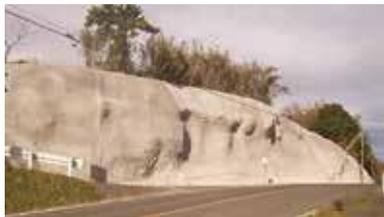
本工法は、既設モルタル面をはぎ取ることなく効率的に補修・補強する技術です。
