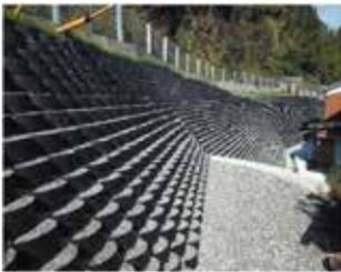
テラセル擁壁工法とは、高密度ポリエチレン樹脂 (HDPE) 製のハニカム状土壌安定枠のテラセル (ジオセル) を展開してセル内に土や砕石を充填し、段積みすることで擁壁体を構築し、切土のり面を保護する柔構造擁壁工法です。
