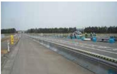
「ミニガードシステム」は、材質が亜鉛メッキスチール材で本体部エレメントとターミナル部(スタート、エンド)から構成された移動式防護柵(プレハブガードレール)です。本システムの特徴は ①エレメント1体が軽量なので重機作業が不要です ②機能的なデザインで安全性と美観性が向上します ③連結性が高くエレメントが曲線なので車両が衝突した場合にダメージが少なく、脱輪・横転を防止し、車両を正しい走行方向(元の車線)へと誘導できます ④曲線半径R=80m程度まで対応できます ⑤材料は全てリース材で産業廃棄物が発生しません
