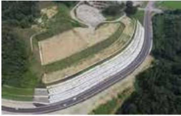
PCフレームはコンクリート部材にプレストレスを導入することで曲げ耐力が高く、耐久性に優れたのり枠である。
