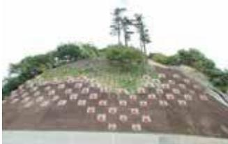
NMグラウンドアンカー工法は、高い強度と優れた防食性能を有しており、温泉地帯や火山地帯の酸性土壌、波の飛沫が当たる高塩害地などの厳しい環境に適応します。
