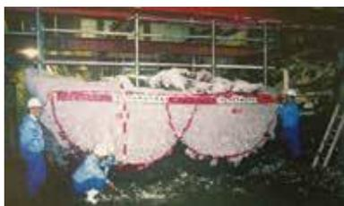
本工法は、従来工法では不可能であった水平・斜め・大深度・水域における施工が可能な高圧噴射攪拌工法です。最大の特徴は切削した排泥の排出機構にあり、先端部造成装置の排泥吸引口から発生汚泥を強制的に専用管の中へ吸引して地表へ回収することにより、広範囲の施工が可能となりました。
