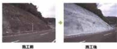
既設吹付モルタルは、経年変化により劣化やひび割れ・剥離・地下水等の影響による地盤の風化・空洞化が生じています。のりフレッシュ工法は、この老朽化した既設吹付モルタルを取り壊すことなく、増厚工（アンカーボルト・空隙充填工）で補修することができる工法です。
