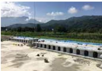
自在な設置形状：1個が1m×2mのブロックを並べるだけなので、自在な平面計画が可能。狭い場所や、歪な土地でも、無駄のない設置ができます。
