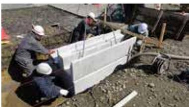
標準型の貯留容積は0.62m<sup>3</sup>：複数個を積み重ねることで多量の流出水量にも対応可能。
