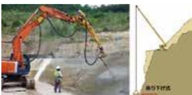
Robo-Shotは、のり面吹付工事の分野でも課題となっている作業員の高齢化や熟練工の減少に対応する工法として開発した機械吹付システムです。緊急性の高い災害現場などにおいても短期間で安全な施工が可能です。（第27回日本建設機械施工大賞・選考委員会賞受賞）
