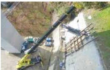
スパイダードリリング工法は、市場単価を適用できない特殊な条件下で鉄筋挿入工を施工するとき、現場の条件を考慮して「足場タイプ」「無足場タイプ」「クレーンタイプ」の3つの作業形態から最適なものを選択します。◆施工箇所がきわめて狭い場所、高低差の大きい場所、または逆巻き施工で多くの工種が輻輳する現場など、特殊な条件にも対応できます。◆施工する地盤の条件に応じて「単管削孔」もしくは「二重管削孔」のいずれかを選択することができるので、不安定な地山にも対応します。◆スパイダードリリング工法なら、足場の設置撤去や削孔機械移設など、仮設工の工事費や施工日数を縮減し、鉄筋挿入工の施工を大きく改善できます。
