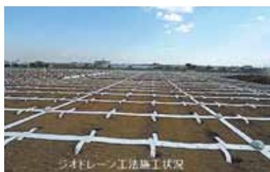
ジオドレン工法施工状況
