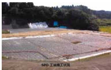
SPD工法施工状況
