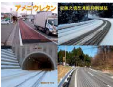
アメニウレタン 空隙充填型凍結抑制舗装
