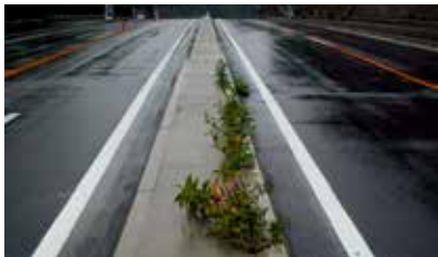
【施工して数年後の状況】 左側は「雑草防止工法」施工。隙間がなく雑草が生えません。 右側は通常のブロック施工。隙間から雑草が繁茂しました。
