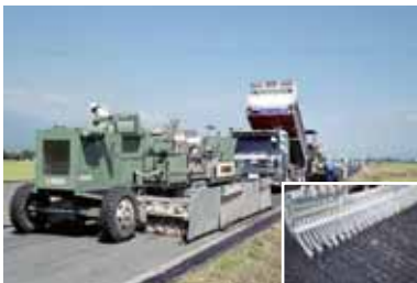
施工状況とスカリファイヤの作動状況
