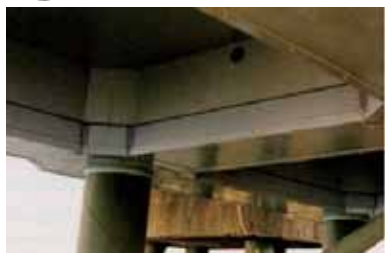
FRP永久型枠による断面修復工法
