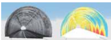
レーザー計測例 内空変状解析例
