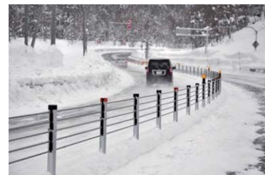
設置状況（一般国道275号音威子府村天北峠）
