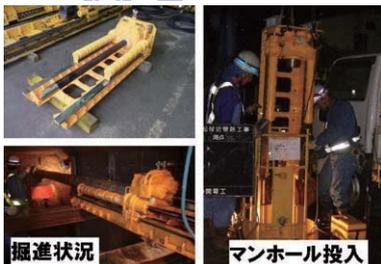
狭隘な作業スペースでの施工を可能とした超小型小口径推進機
