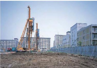
SAVEコンポーザーは、無振動・低騒音工法であり、周辺環境へ与える影響が少ないため、既設構造物に近接した施工が可能です。砂質土のみならず、粘性土などさまざまな地盤に適用できます。従来のサンドコンパクションパイル工法と同様の改良目的に使用でき、同等の改良効果が得られます。砂の他に碎石、リサイクル材などの各種材料も使用できます。同一施工機で容易に杭径を変えることができるので、サンドドレーンとの複合パイルの造成も行えます。
