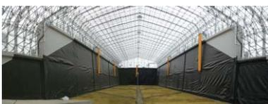
八戸市新処分施設は、現在稼働中の既設処分場に代わり、新たに建設される埋立容量約21万4千㎡の被覆型最終処分場である。処分施設本体は、約6万㎡の鉄筋コンクリート構造物であり、膜屋根を有するインドア形式の処分場である。約32万㎡の大規模な敷地造成工事は、主に十和田・八甲田系の軟弱な火山灰質粘性土(八戸、高館ローム)を対象としたものであった為、適切な安定処理を行い実施した。4区画に分かれた処分施設の内面(直壁面、高さ16m)に設置する遮水シート(高密度ポリエチレン製)は、今回新たに開発したシート固定方式を採用し、短工期での施工を実現した。
