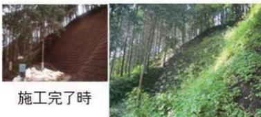
長繊維補強土（ロービングウォール工法）は、従来コンクリート構造物で覆われていた斜面・のり面を長繊維を混入した土構造物とその表面を植物で覆うことにより、自然環境に配慮しつつ、災害を防ぐ技術です。
