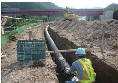
高速道路・高規格道路の雨水排水用として使用されている高密度ポリエチレン波付管。
