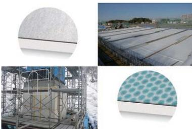
コンクリート養生は、頻繁な給水を行い、寒冷地などの厳しい条件下ではジェットヒーターや断熱性の材料による保温養生を行うことが一般的です。これらは湿潤と保温養生を別々に行うため施工性が非常に悪く、特に傾斜部は断熱材の固定が困難な現状にあります。
