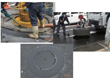
人孔鉄蓋後付工法「エポ工法」は、舗装工事前に人孔上部を撤去しておくことにより、人孔上部の突起が無い状態で、掘削、切削、舗装材料の敷均し、転圧等の各作業を支障なく行うことが可能になる工法です。表層舗装後に埋設されている人孔部分を円形に切断し、人孔上部の据付、復旧を行います。
