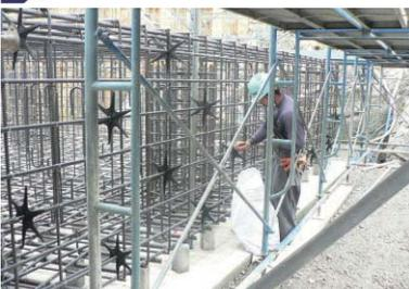
従来、土木分野における鉄筋のかぶり厚確保に関しては、主に熱膨張率への懸念からコンクリート製スペーサの使用が推奨されてきた。しかし、一般的なコンクリート製スペーサは「重い、割れる、鉄筋から外れやすい」という欠点があり、現場では改善への要望が多かった。本技術は温度応力、乾燥収縮応力解析結果に基づき、製品設計を行ったことにより、プラスチック製でありながら従来のコンクリート製スペーサと同等のひび割れ抑制効果を有す。
