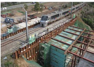
**切羽掘削のないボックスカルバートの非開削トンネル施工法**
