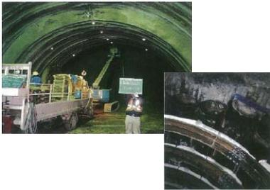
土木工事の構造物を構築する際には、トンネル・シールド・立坑・函渠など地山を掘削する工事が発生します。掘削に際しては、地山の地質、地山の土被り、荷重の関数的特徴等が変化するのでトンネルは複雑な荷重を受けます。この荷重を支える為に支保工が用いられます。支保工は、荷重が掛かる前に設置されますが地山と支保工及び地山へ伝達させる支保部材が必要となります。この目的の為に開発された画期的な沈下抑制方法が「プレロードシェル工法」で、地山と支保工の間に袋体（ジャケット）をセットし、袋に無収縮モルタルを充填することで、支保工と地山が一体化され、確実な支保能力を発揮します。
