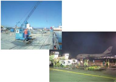
静的圧入締固め工法（コンパクショングラウチング工法）は、低流動性の注入材を圧入して地盤を圧縮強化する静的な締固め工法です。
