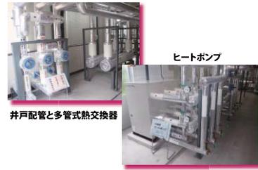
井戸配管と多管式熱交換器
