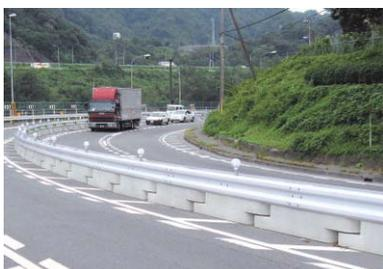
曲線カーブに自在に対応できる、車両用防護柵を設置する際に使用するプレキャスト連続基礎ブロック
