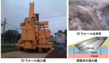
新世代の環境配慮型遮水壁工法として開発実用化した本工法は、原位置土と天然粘土鉱物を粉体状で混合攪拌させて造成する地中遮水壁です。セメントを一切使用しない粘土遮水壁であるため、十分な遮水性能と、地震時の変形追随性や自己修復機能を有しています。本工法の用途としては、遮水壁としての適用はもちろんですが、最終処分場などの有害物質を含んだ汚染土壌の封じ込めにも適用可能です。
