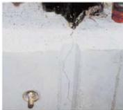
A・BL部材の組み合わせにより、2mを越える壁厚でも30%以上の断面減少率を確保でき優れた誘発性を持っています。A部材には非加硫ブチルゴム止水材を積層しており、鉄筋かぶり部に設置することで高い止水機能を発揮し鉄筋の腐食防止効果と共にコンクリートの耐久性向上に貢献します。特殊注入チューブを使用し、ひび割れ部に樹脂を充填することで強度回復も可能です。
