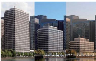
鹿島カットアンドダウン工法は、いわゆる『だるま落とし』のようにビル外観をそのままにジャッキで建物を支持して下層階から解体する工法で、従来の工法に比べて騒音や粉じんの飛散を抑制するなど環境への影響を大幅に減少できます。鹿島では、2008年に中高層ビルを下から解体する本工法を実用化して鹿島日本社ビル2棟を解体し、さらに環境性能向上と短工期化を図り、2013年「りそな・マルハビル」(高さ108m)を1階から24階まで、1フロア3日という従来の約半分のサイクルで解体を実施しました。
