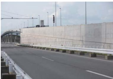
二重壁構造補強土壁「アテムウォール」は、コンクリートパネルによる壁面材(外壁)とジオテキスタイルで補強された補強盛土体(内壁)との間に排水層を設けた二重壁構造を持つ補強土壁工法です。このたび、(財)土木研究センターにおきまして建設技術審査証明を取得し、①主要材料の強度特性②地震時における安定性③施工性④維持管理性能に対して優れた機能を有している事が審査・証明されました。
