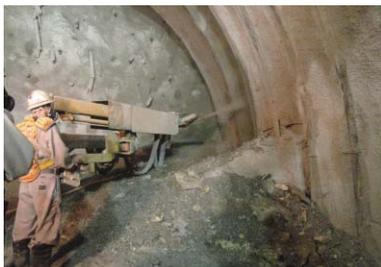
デンカΣショットSHは吹付け後10分で3N/mm<sup>2</sup>程度強度発現する瞬結のNATM吹付け工法です。
