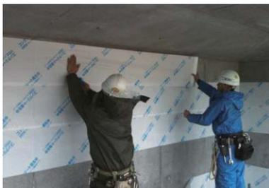
コンクリートが構造材料として所定の性能を発揮するには、打設後十分に硬化するまでの一定期間、適切な温度と湿度のもとで養生される事が理想です。この養生期間中には、セメントの水和反応が十分に進行して、緻密な組織が形成されるよう、コンクリートの乾燥を抑えることが重要です。特に蒸発が激しい表面を保水養生することが、乾燥収縮対策には有効です。3M™コンクリート保水養生テープ 2227HPは、型枠を取り外した直後のコンクリート表面に貼り付け可能なので、表面からの水分蒸発を大幅に抑制し、効果的に保水養生することができます。テープの粘着力だけで簡単に張り付けることができ、そのまま3カ月養生してもほとんど糊残りなく容易に剥がせます。
