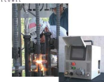
従来ガス圧接のアセチレンの替わり、環境にやさしく安全性が高い天然ガスを用いるガス圧接工法です。
