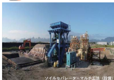
ソイルセパレータ・マルチ工法（設備）
