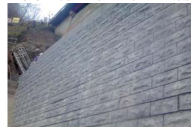
本沢第二砂防えん提改築工事
