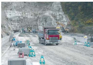
濁沢第6砂防堰堤工事
