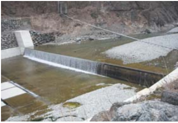
葛葉上流床固工補修工事
