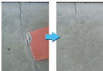
左：ゴムヘラによるCS/Pテ充填 / 右：補修完了
