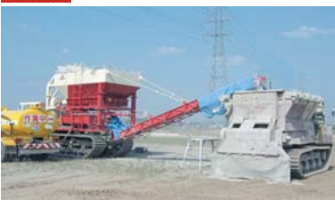
イビデン(株)神戸事業場特炭施設建設工事(モイストセメント製造状況)
