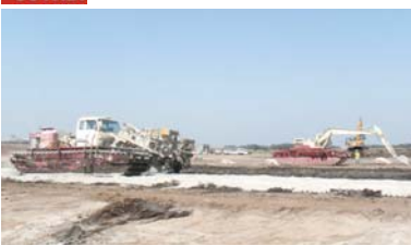
玉作水門土砂掘削運搬工事
