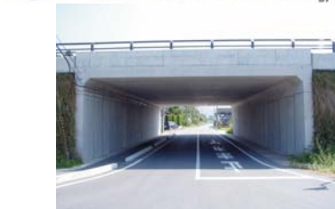
桃生登米道路 嵯崎地区函渠工 (10.6×5.7)
