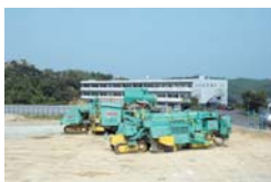
岩盤切削工法の全景
