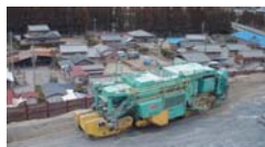
住宅近接部での施工
