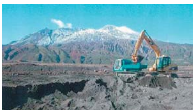
桜島の無人化施工状況
