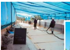
現場 発泡ウレタン施工状況
