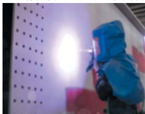
常温金属溶射作業状況
