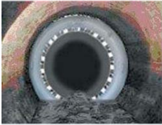
EPR工法 エアーマールド型 管径1500mm
