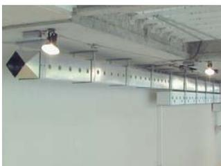
コルエアダクト側面に多孔を設け、ダクト本体から直接吹き出す仕様。
