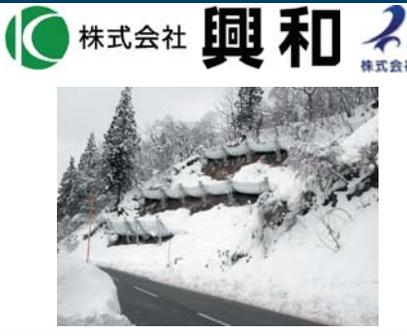
**コンクリート基礎を必要としない、軽量で設置が容易な経済的な防雪施設です。**
