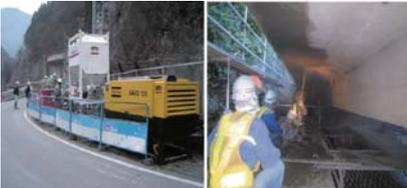
①施工状況全景 サイロシステム全景 ②施工状況写真 橋桁断面修復状況
