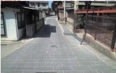
福島県白河市の施工事例
