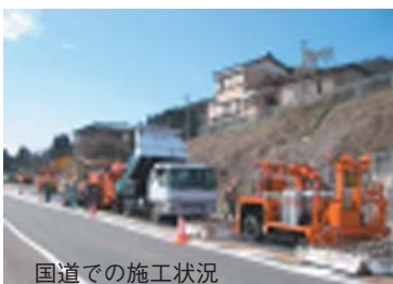
国道での施工状況
