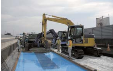
一般国道 50 号大平高架橋 (関東地方整備局)
