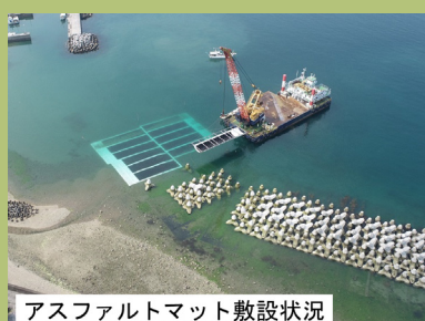
アスファルトマット敷設状況
