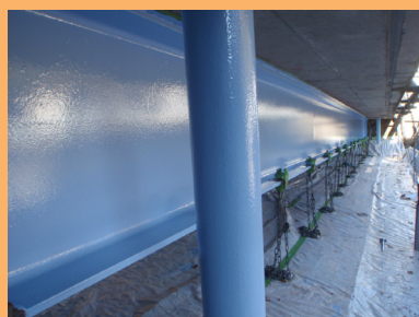
IPH工法・AT工法・サビバリヤー (株)オカダエンジニアリング
