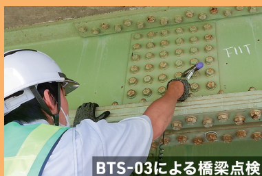
BTS-03による橋梁点検
