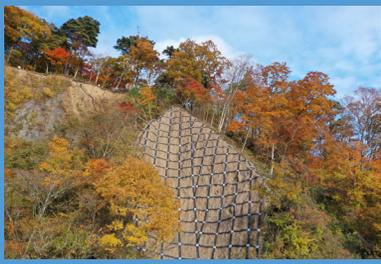
**コンクリートを使用せずに『侵食防止、小規模崩壊を抑制する斜面安定工法』**
