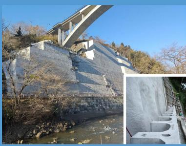
**PCW工法は、気泡混合軽量土を使用した工法で、安全性、作業性の向上、工事費の削減を追求した工法**
