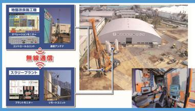
**地盤改良工法の自動打設システム**
