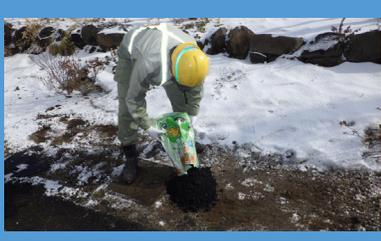
**水をかけて締め固めるとすぐに固まる袋詰め常温アスファルト混合物**
