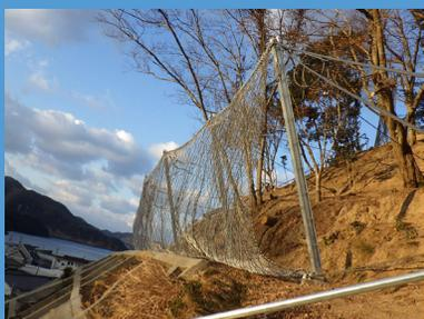
**高エネルギー吸収型落石・土砂防止柵ハイジュールネット／高張力型ロープ伏工ハイテンネット**
