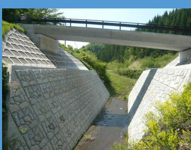
**背面掘削が困難な河川護岸工事に有用な地山補強土工法**
