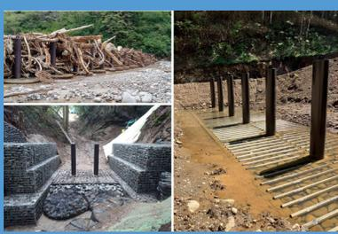
**コンクリートの使用量を大幅に削減させた『流木対策施設』**
