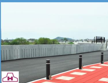
堤防の嵩上げをパラペット構造によりプレキャスト化、
