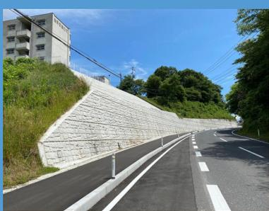
**表面工にプレキャストパネルを使用した地山補強土工法
