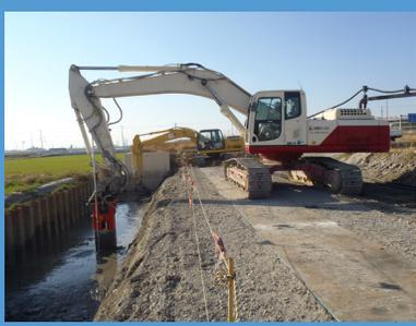
**浅層・中層混合処理工法**
