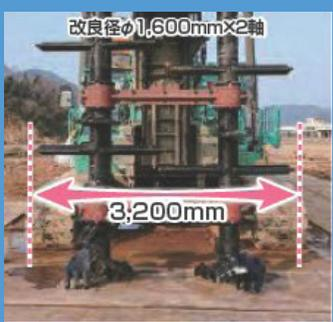
**次世代型大口径深層混合処理工法**
