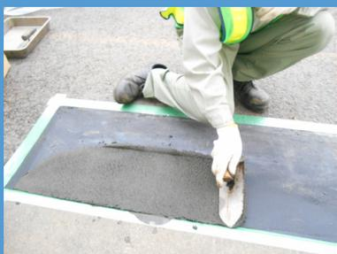
**コテだけで施工できる、速硬型のポリマーセメント系段差修正材**
