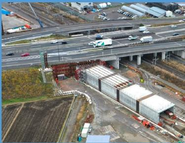
鉄道または道路下に非開削でトンネルを構築する
