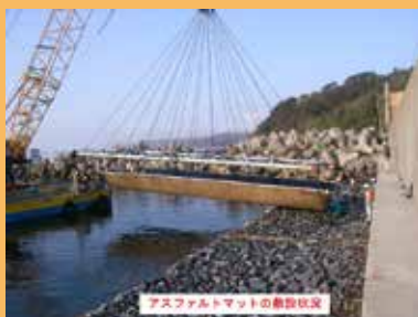
アスファルトマットの敷設状況
