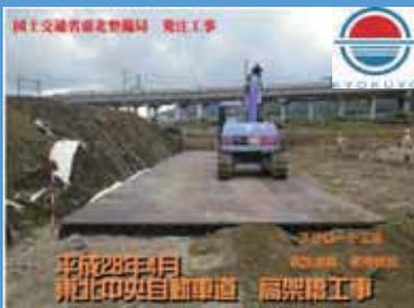
**NETIS登録工法。簡易仮設材として利用。軟弱地盤でも上部に敷鉄板を敷く事で重機・車両の通行可能に！**
