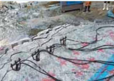
無発破でコンクリートおよび岩石を破碎する工法に使われます
