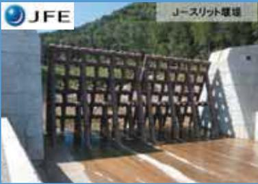
土石流・流木を確実に捕捉する
