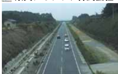
施工後9年経過 左側: 従来工法 (炭カル)、右側: アルプラス工法
