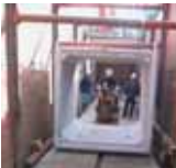
腹起・切梁下でのボックスカルバート搬送(横引)据付施工
