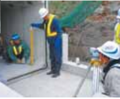
レベル測量器等を使用し精度の高いmm単位の据付作業(ボックスカルバート)
