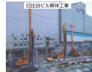
日比谷ビル解体工事
