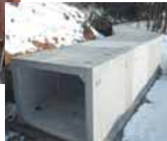
マルチレベル工法・マルチ搬送(横引)工法併用直線・曲線部施工
