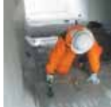
マルチレベル治具を使用した高さ調整(ボックスカルバート)
