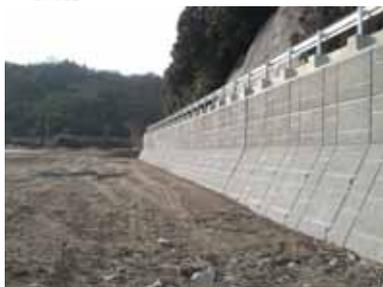
ワイドウォール工法は、従来のもたれ式擁壁の前面に垂直な壁を設けることで、従来の工法を大きく変更することなく、擁壁上部の路肩、土地を拡幅することが出来る画期的な工法です。車道・歩道・宅地の拡幅が大型積みブロックの施工完了と同時に完成しますので、従来工法と比較してトータルコストの大幅削減が可能となります。1.5車線の道路整備を含む様々な道路拡幅工事のほか、用地などに制約がある山間部の工事などでも活用可能です。
