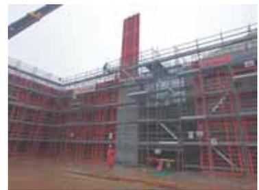
専用のハンマー1本で型枠組立が可能です。型枠を組み立てる作業の流れをシステム化することで、従来の工法より型枠の大型化、作業の省力化、施工スピードの向上が図れます。
