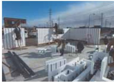
S I S J 工法は、内外両断熱型枠材を使用した鉄筋コンクリート型枠壁式構造の建築工法です。難燃性発砲ポリスチレン (EPS) を用いた型枠で、コンクリート打設後はそのまま内外断熱材として脱型をせずに利用でき、工期短縮が図れます。
