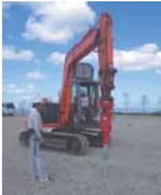
地面に直接打ち込むだけ、事前作業も事後養生も残土処理も不要です。基礎打ち直後に上物の設置ができ、将来、撤去する時もとても簡単で、30度程度の法面でも対応可能です。作業日数の短縮とコストダウンを両立します。グループ全体で10万本以上の施工実績を誇っています。
