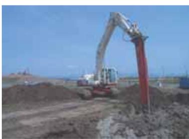
「S T B-PMX工法」は軟弱地盤にバックホウの先端に取り付けた左右対の円形直接駆動方式の攪拌機を用いた浅層・中層地盤改良工法です。
