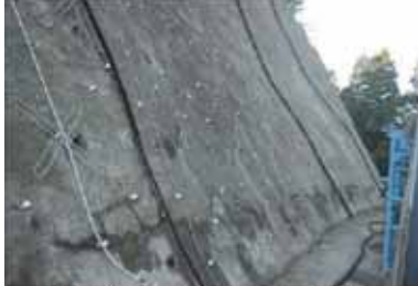
部材設置完了（繊維補強モルタル吹付前）
