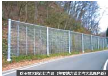
秋田県大館市市内町 (主要地方道比内大葛鹿角線)
