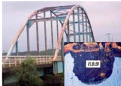
塩害環境等における鋼構造物の塗替え塗装において、残存錆中の劣化因子(塩化物イオン等)により、比較的早い時期に再劣化に至ることが問題になっている。CSCシステムは、鉄筋コンクリートの塩害対策で実績のある「SSI工法」の考え方を応用して、鋼構造物を塩害環境等の腐食を抑制する画期的な防錆塗装システム。通常のケレン作業では除去しきれない孔食部の腐食性物質に対し、下塗材に配合した塩分吸着剤が直接作用して、イオン交換反応により塩化物イオンを吸着・低減し、代わりに亜硝酸イオンを放出することにより、孔食部の腐食性を低減する。
