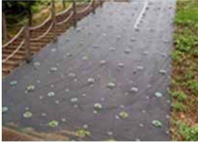
植栽帯において防草シート(ザバーン®、4層スパンボンド不織布)により維持管理コストが減少され、植栽ワッシャーにより、植物の成長を促進します。さらに、防草シートのカット、土の除去を同時に行えるホールオープナー(専用穴開け機)を使用することで普通作業員でも作業が可能です。
