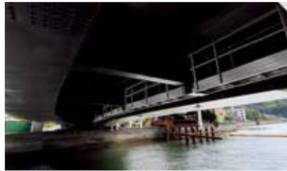
**新設橋はもちろん、既設橋にも設置可能な軽量で耐食性の高い機能的なアルミ合金製検査路**
