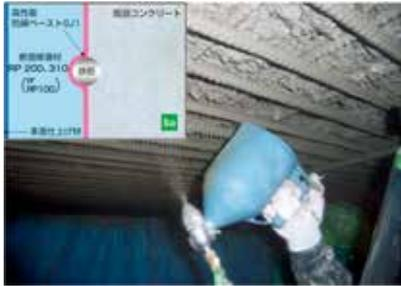
近年、飛来塩分や凍結防止材などに由来する塩化物イオンがコンクリート構造物に浸入し、鉄筋が腐食する塩害が問題となっている。SSI工法は、錆やコンクリート中に含まれる塩化物イオンに直接作用する「塩分吸着剤」を活用した断面修復工法で、抜本的な塩害対策が可能となる。鉄筋ケレン作業では除去しきれなかった錆や躯体に含まれる塩化物イオンを、イオン交換反応により塩分吸着剤が吸着・低減し、代わりに亜硝酸イオンを放出することにより、鉄筋周辺を腐食環境から防錆環境へと改善して、長期耐久性を回復する。
