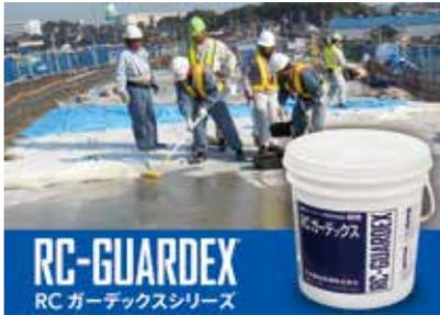
本製品は反応性の高いナノサイズの「[けい]酸塩」が主成分。内部に浸透しカルシウムイオンと反応して躯体を緻密化。アルカリ付与、防水・止水、クラック補修・抑制、塩害・白華現象の防止等に効果を発揮し、予防保全・維持補修管理や耐久性向上、長寿命化・ライフサイクルコストの低減が可能。他工法と合わせて使用可能。本材料は材齢の影響を受けず40年以上経過した躯体での効果も実証済。無色透明で無臭の水系無機製品なので、仕上面の意匠や質感を損なわず、比較的少ない工程・短時間で施工可能。紫外線劣化もなく環境にも優しい製品です。
