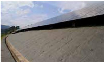
**厚さ3ミリの改質アスファルト系シートを使用した高性能・高品質防草シートです。**
