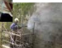
**ドイツ ファルヒ社 WJによるコンクリート補修の表面処理**
