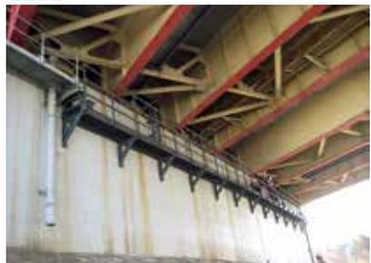
**従来の鋼製検査路に比べて材料をGFRPに換えることで、高い耐久性と軽量化を実現しました。**
