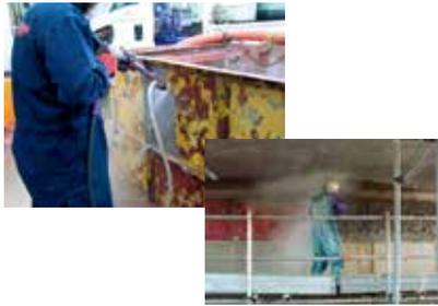
塗膜除去工法 コンクリート構造物の塗膜除去は、旧塗膜に隠れている劣化部分を検出するために必要な作業です。剥離剤の使用が制限されている中で、50Mpmの水圧で100℃の温水を使用することで、剥離が可能です。また、鋼桁の塗膜除去にもWJの使用が検討される中で、アブレッシブ工法による砂と水と一緒に噴射する機材によりさらに効率の良い施工が可能です。
