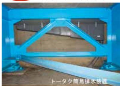
**橋梁 伸縮装置遊間部からの漏水を橋下側から設置したポリエチレン製排水装置で集排水する工法**
