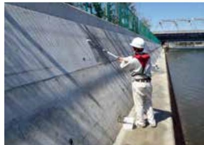
「T&C防食-塩害用-」は2種類の液体をコンクリート表面に塗布することで劣化因子の侵入を効果的に抑制し、特に塩害抵抗性を飛躍的に高めることを達成した技術です。塗布する2種類の液体はともに無色透明で浸透性が高く、最初に塗布するA液(ケイ酸塩系)はコンクリート内部に浸透して緻密化し、次に塗布するB液(シラン系)はコンクリート表面に撥水性を付与します。本技術はケイ酸塩系とシラン系の両者の特性を併せ持つハイブリッド型の表面含浸材と言えます。また無色透明の液体を塗布するためコンクリートの外観を変えることなく、表面被覆工法より維持管理しやすいという特徴があります。
