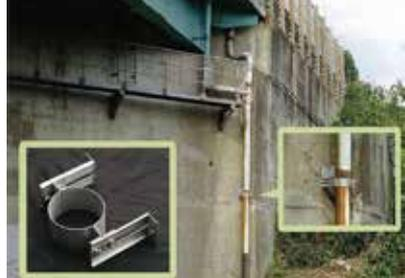
**橋梁躯体からの詳細な距離計測がいらぬ橋梁排水管伸縮自在取付け金具**
