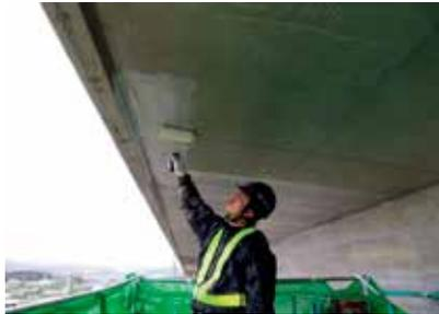
ケイ酸塩系+シリコン系+透湿塗膜の3つをブレンド。含浸材と塗膜の両方の長所を兼ね備えた「ハイブリッド型一液性水性塗料」である。塗布することで、コンクリート構造物における、中性化、塩害などの劣化を抑制することができる。
