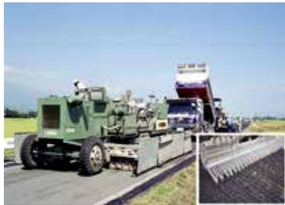
**タックコート不要の、ヒータ車とアスファルトフィニッシャーによる薄層オーバーレイ工法**
