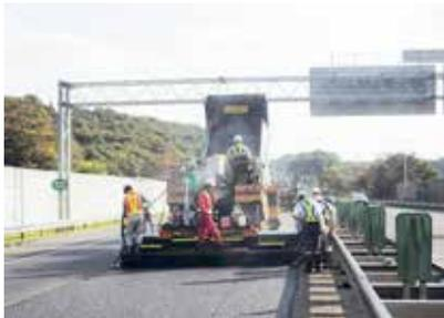
POSMACは、乳剤散布装置付アスファルトフィニッシャーで、多量の高濃度改質乳剤(1.2l/m<sup>2</sup>以上)を均一散布・即時分解させるのと同時に、ポーラスアスファルト混合物を舗装します。散布された高濃度改質乳剤は、タックコートとしての役目を果たすと共に、混合物下部の空隙に充填されポーラスアスファルト混合物を遮水機能を有する混合物にし、雨水から基層を保護します。さらに既設舗装路面のひびわれ部へのアスファルト充填によりリフレクションクラックを抑制します。
