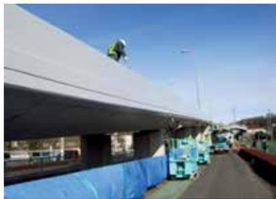
**1液硬化型ウレタン樹脂による連続繊維シートを用いずに剥落性能を発揮できるコンクリート剥落防止対策工法。**
