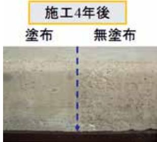
吸水抑制効果を発揮する液体状の材料である表面含浸材を刷毛やローラー等を用いてコンクリート表面に塗布し、内部に含浸させることで、主に凍害・塩害に対する耐久性を高める技術です。塩化物イオンの浸透速度を抑え、複合的な劣化作用を受ける道路橋の地覆コンクリートや剛性防護柵コンクリートのスケーリング対策として有効です。
