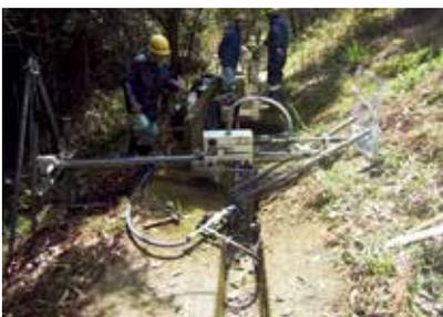
**のり面の浅層崩壊防止対策としての水抜き工法**
