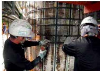
**既設RC橋脚の鉄筋埋設型PCM巻立て工法 橋脚耐震補強工法・AT-P工法**
