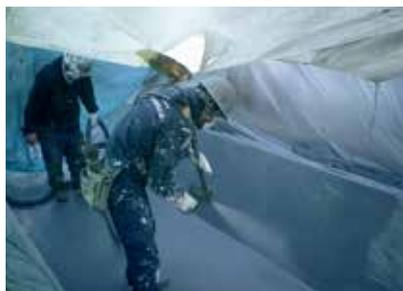
**超速硬化スプレーウレタンを用いた大幅な工期短縮が可能なコンクリート構造物地下防水・水路長寿命化工法。**
