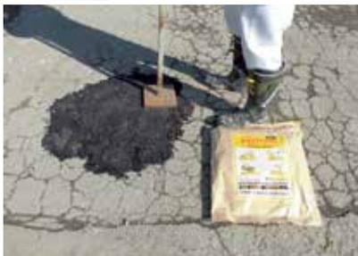
コールドパーミックスは、高耐久型常温補修用ポーラスアスファルト混合物です。従来の補修用混合物よりも強度発現が早く、長期安定性・耐水性に優れています。雨天時にも施工可能であり、気温の影響を受けないため、取り扱いが簡単です。混合物としての安定性も高いため、施工後は早期の通行が可能です。また、5mmTOP混合物なので補修形状に合わせることが簡単、未開封であれば長期貯蔵が可能などの特徴があります。
