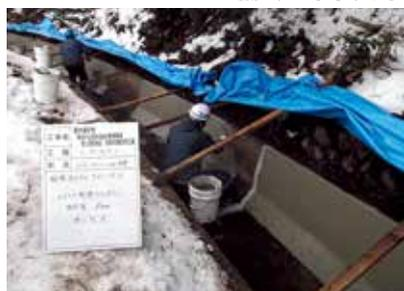
既存コンクリートに無機反応型改質材を含浸させ、表層を強化し、次に付着性の高い薄付仕上げモルタルで表面の不陸調整を行うことで、水路断面積を減らさずに粗度係数を回復します。更に無機質反応型改質材とシリコンを主成分とした撥水材を上塗りする塗布型補修工法です。現場状況によっては、断面修復材の変更もでき、2軸、3軸ビニロンメッシュ・ガラス繊維シート敷設補強も可能です。
