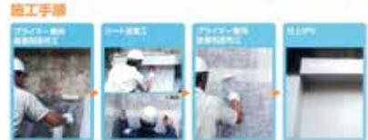
KK クラックリペアシート工法は、工期短縮したコンクリート片はく落防止工法です。不織布複合ネットとプライマー兼用接着剤を用いることにより、工程を減らし、工期を短縮することができます。また、複合ネットのシートの特徴から、出隅、入隅の作業性に優れています。本工法は、首都高速株式会社 橋梁構造物設計要領 コンクリート片剥落防止編 平成18年8月版 剥落防止工の評価基準 A種 およびB種、阪神高速道路株式会社 コンクリート構造物表面保護工 中防食 C種に適合しております。
