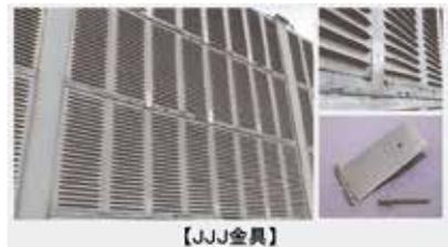
**簡易で安価な補強・補修金具で遮音壁吸音板の長寿命化を実現**
