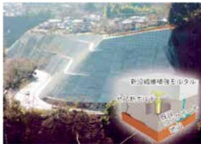
ニューレスプ工法は、既設吹付法面の機能が喪失する前に、老朽化したコンクリート(モルタル)などをはつり取ることなく補修・補強することにより、法面保護効果を高める法面再生技術です。
