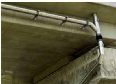
**通常は高価で重いステンレス管を特殊スパイラル製法等により低コスト、軽量化を実現した橋梁専用添架排水管**
