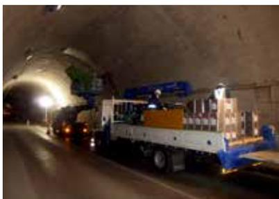
**40倍発泡ウレタンを用いた既設道路・水路トンネル裏込注入工法(NETIS 設計比較対象技術 平成26年12月8日~)**
