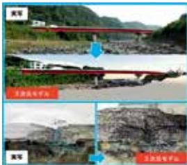
**多視点画像計測によるインフラ構造物(橋梁)の3D技術**
