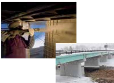
**乾式吹付工法は、長距離・高所への材料運搬が可能で、鉄筋裏への充填性に優れている。また一層50mm厚の吹付が容易に出来、一日当たりの施工量が多いため工期の短縮を図れる技術。**
