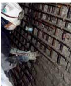
アーマ#600、600Pは、超微粒子セメントを使用した無機系のひび割れ注入材で、表面ひび割れ幅0.2mm程度まで注入が可能で、湿潤面の施工が可能です。断面修復材は、施工法に応じて、左官工法用(100P、100PS)、吹付工法用(310P)、充填工法用(520)を取り揃えています。アーマ#100PSは、5時間で10N/mm<sup>2</sup>以上の強度を発現する速硬型です。アーマ#700シリーズは、配合した塩分吸着剤の作用により、躯体に残存する塩化物イオンを吸着・固定し、イオン交換反応で亜硝酸イオンを放出することで、鉄筋の腐食を抑制します。
