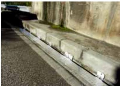
**円型水路における呑口部分の損傷箇所を補強する金具です**
