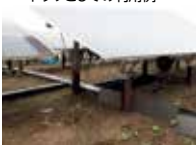
太陽光発電所内でケーブルトラフとしての利用例
