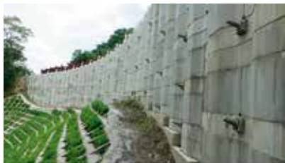
震度6弱の揺れに耐え、国道342号線を守った親杭パネル壁工法(一関市)
