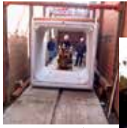
腹起・切梁下でのボックスカルバート搬送(横引)据付施工
