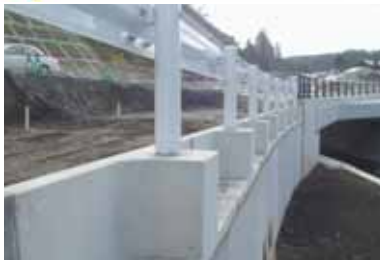
青森県三八地域県民局地域整備部
