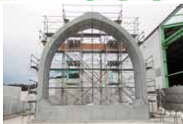
施工実績 宮城県気仙沼市で施工中
