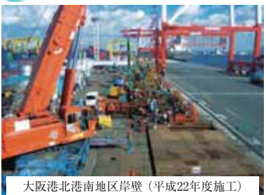
大阪港北港南地区岸壁(平成22年度施工)
