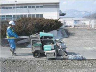
舗装面取工法は、新旧舗装接合面の剥離を最小限にとどめる事を目的としており、従来の垂直カッターで切断後、舗装面を特殊ビットで斜めに面取りをする工法です。これにより面取り部分に凹凸ができ新旧路盤の接着面積も広がるため、接合面を強固なものとし剥離を予防し、道路舗装の平坦性を保ちます。また、この様に舗装打継目の処理を施工する事で、路盤・路床への雨水、雪解け水の浸入を軽減し、凍上災害や通常の道路維持補修管理においてコストを削減することができます。
