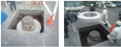
浮上抑制ブロック添付後 浮上抑制ブロック添付状況
