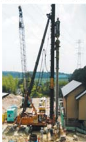
一般国道155号 道路改良工事 (愛知県)
