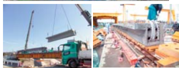
セグメントの架設 セグメントの製作
