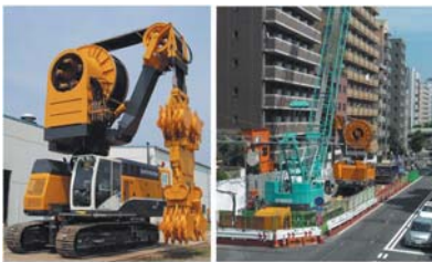
・クアトロサイドカッター ・施工の状況
